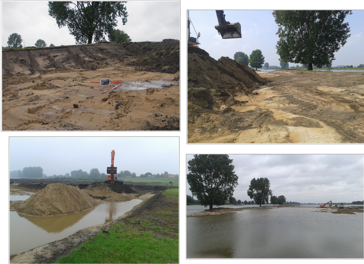
Figuur 6. Maren-Kessel, Kesselsche Waard: Het ontgraven van de getidekreek tot in het beddingzand, rechtsboven is de gelaagdheid op het beddingzand zichtbaar. Rechtsonder: de getidekreek is bijna voltooid.
