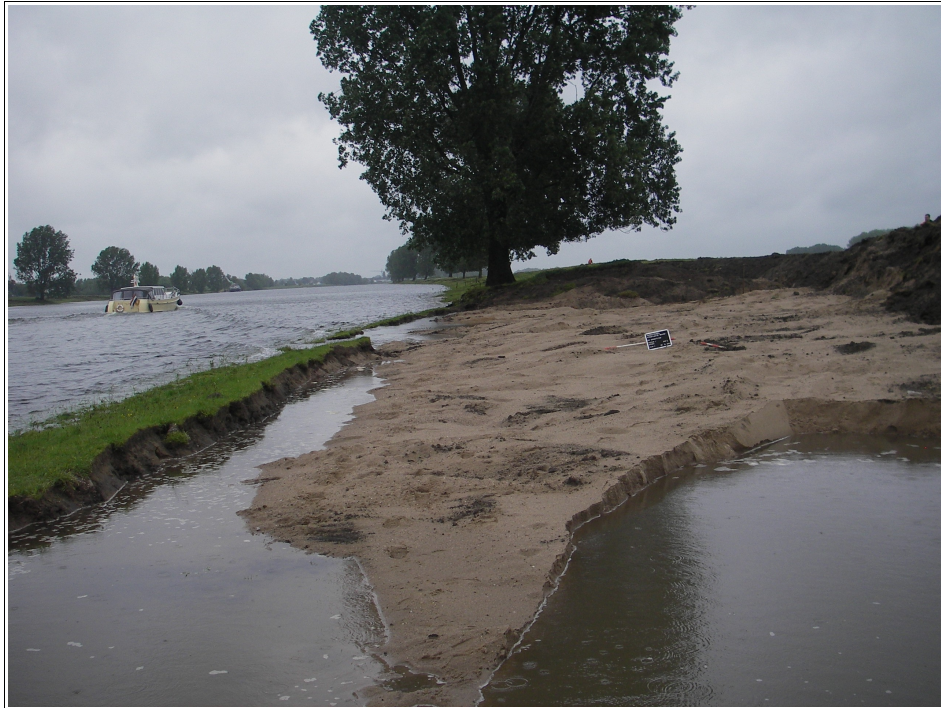
Figuur 3. Maren-Kessel, Kesselsche Waard: Deels uitgegraven monding van de getidekreek op de Maas (links). Op de achtergrond zichtbaar de hoog opgeslibde oevers van de Maas.
